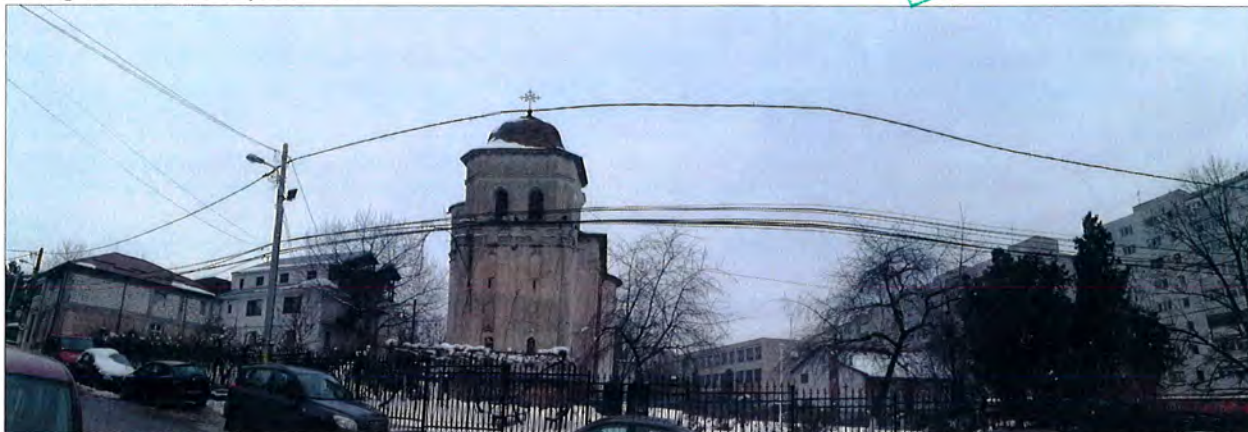
Vedere panoramică fațada vest
