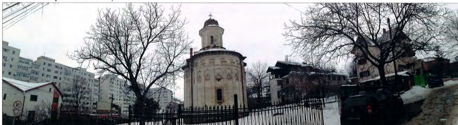
Vedere panoramică fațada est
